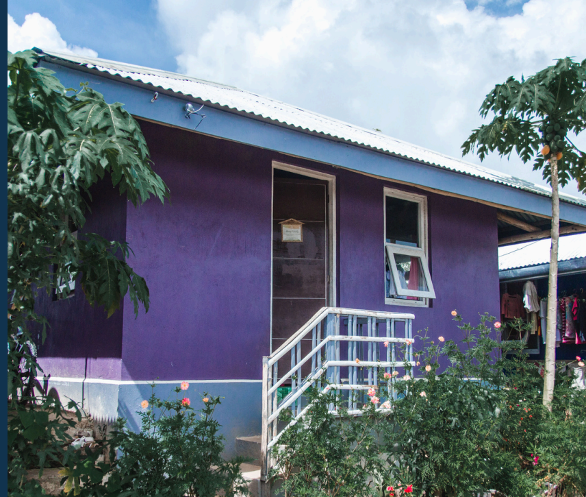
Proyecto de vivienda en la ciudad de Tacloban, Filipinas, de la Fundación Base Bahay y Operation Blessing
