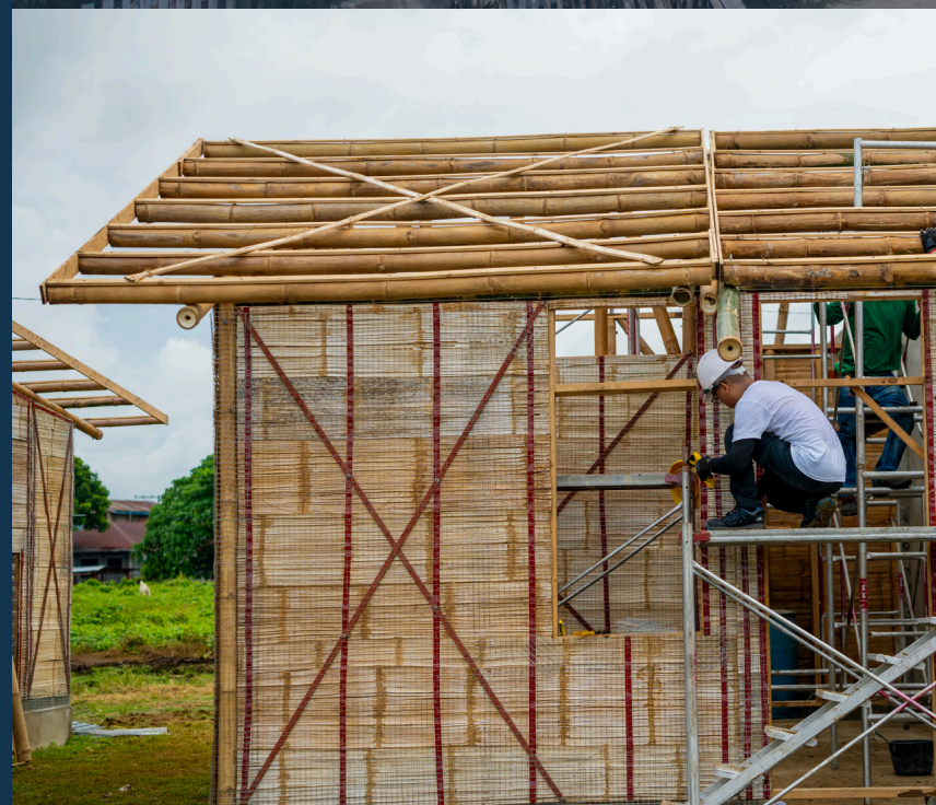
Construcción de una casa MEBC en Nasugbu, Batangas, Filipinas
